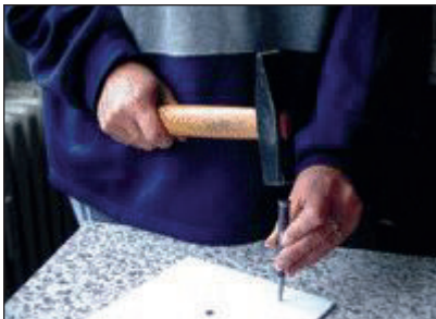
8. Fordítsa át a szerelőlapot, és a megjelölt helyeken pontozóval jelölje át a furatok helyét.
