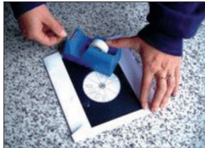
6. A sablonra helyezze rá az asztal tartozékát, a szerelőlapot. Ügyeljen arra, hogy a szerelőlap a berajzolt vonalon legyen.
